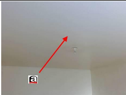
Photo n° PhA002 Localisation : Entrée; Dégagement; Chambre 1; Chambre 2; Placard; Séjour; Placard 2 Ouvrage : 4 - Plafonds et faux plafonds - Plafonds Partie d'ouvrage : Enduit à base de plâtre lissé ou taloché Description : Enduit à base de plâtre lissé ou taloché
