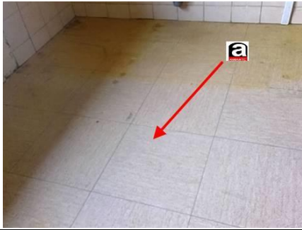
Photo n° PhA001 Localisation : WC; Salle de bains; Cuisine Ouvrage : 5 - Planchers et planchers techniques - Revêtements de sols Partie d'ouvrage : Dalle de sol Description : Dalle de sol
